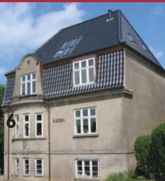
1 Stampesvej 33 - Den oprindelige tagform er bevaret med et nyt mansardtag i sortglaseret tegl
