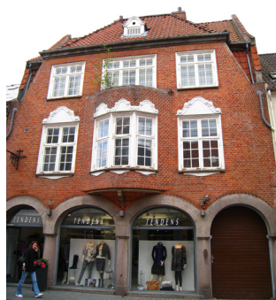
Butiksfacade md respekt for det oprindelige udtryk
