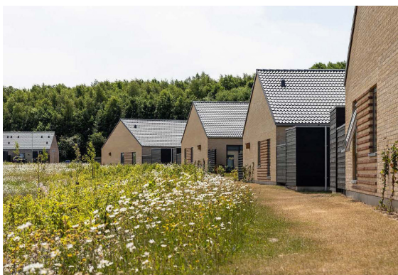
Figur 3: Foto af rækkehusbebyggelse med facader i blank mur med detaljer i murværket ved vinduer. Tage er sadeltage uden udhæng. Udhuse og hegn ved bolig er udført i sortmalet træ.
