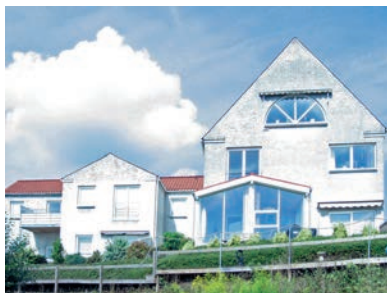
Diplom: Andelsboligforeningen Vejle Fjord, Bybækvej 11. Ejer: Andelsboligforeningen Vejle Fjord. Bygherre: Escon Entreprise A/S. Arkitekt: Steffen Westergaards Tegnastue A/S.
