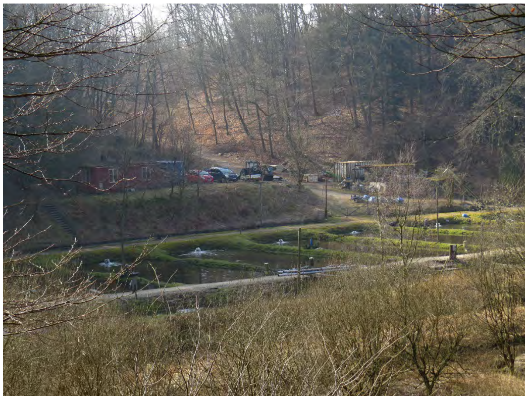
Foto 4: Dambruget set fra vandresti nord for dambruget (zoomet ind på eksisterende bygninger).
