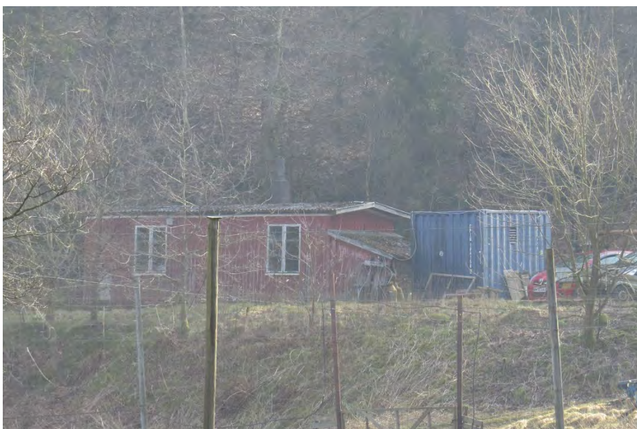
Bygning med frokostur, som nedrives. Containeren til højre for bygningen fjernes.
