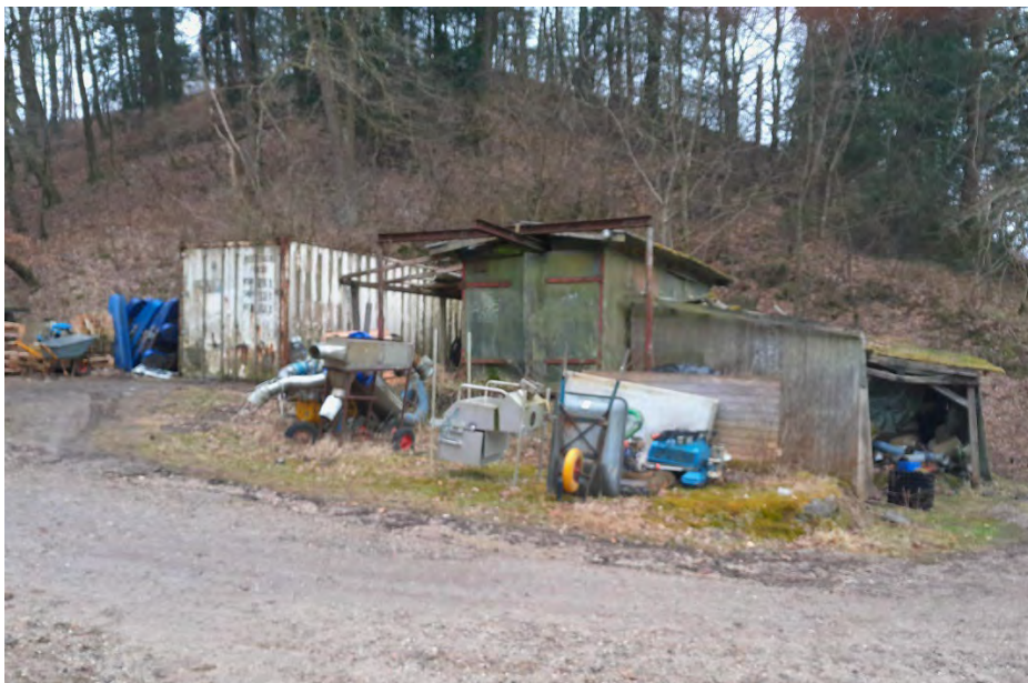
Gammelt hakkehus, der nedrives. Containeren til venstre for det gamle hakkehus fjernes.
