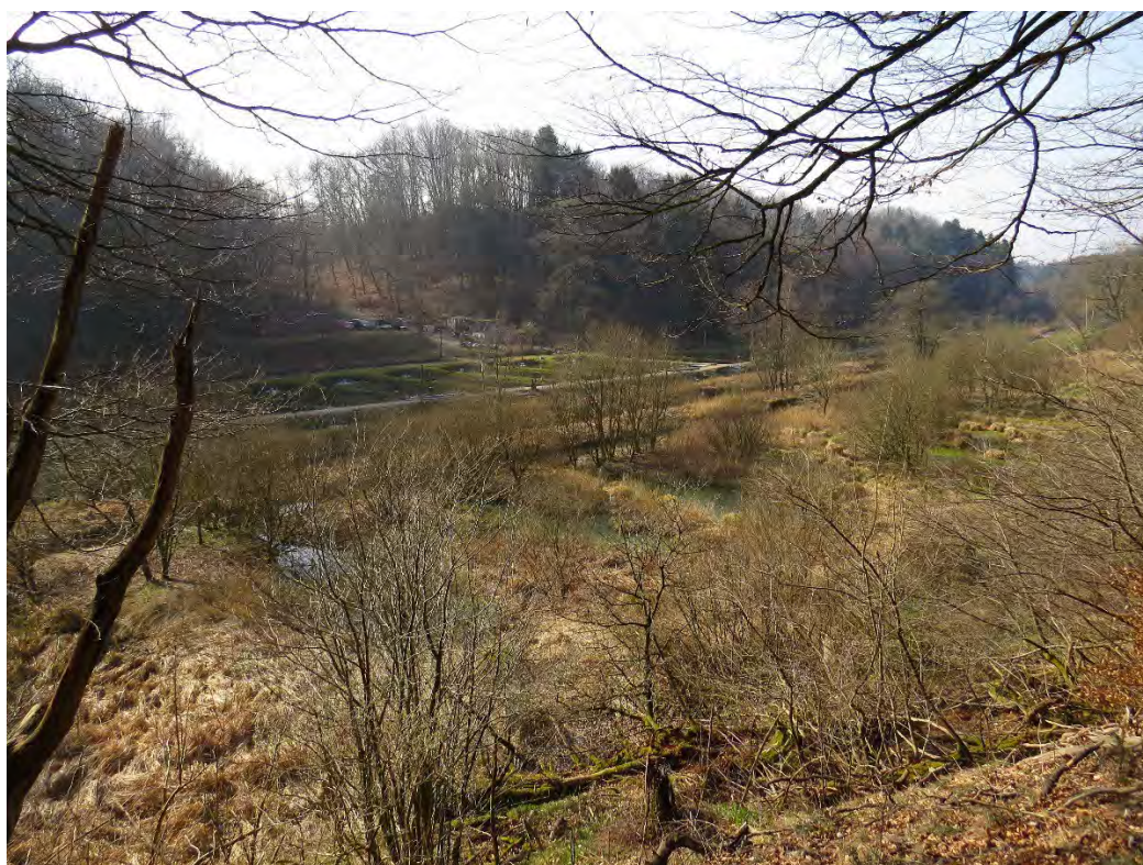
Foto 3: Dambruget set fra vandresti nord for dambruget.
