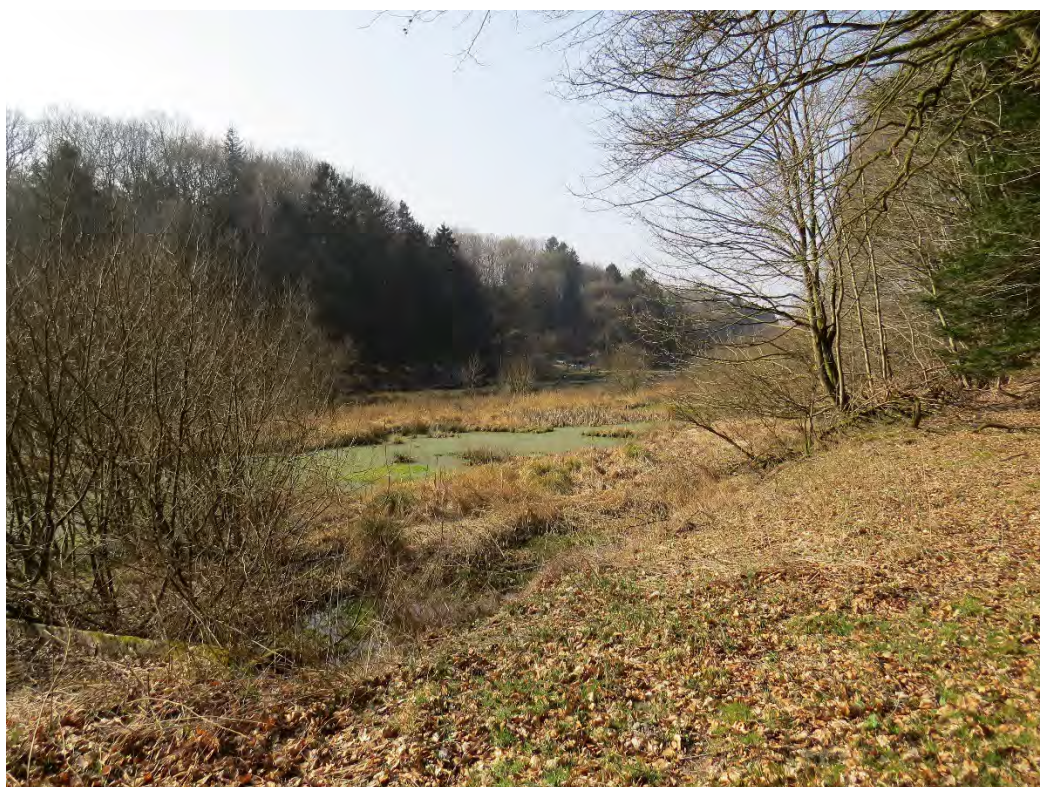
Foto 5: Dambruget set fra vandresti nord for dambruget.
