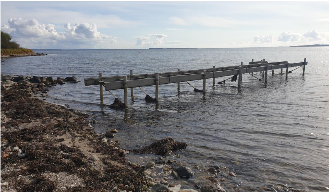
Eksempel på en brotype der ikke kan opnå tilladelse. Det bærende skelet er af metal og tages ikke ned om vinteren.
