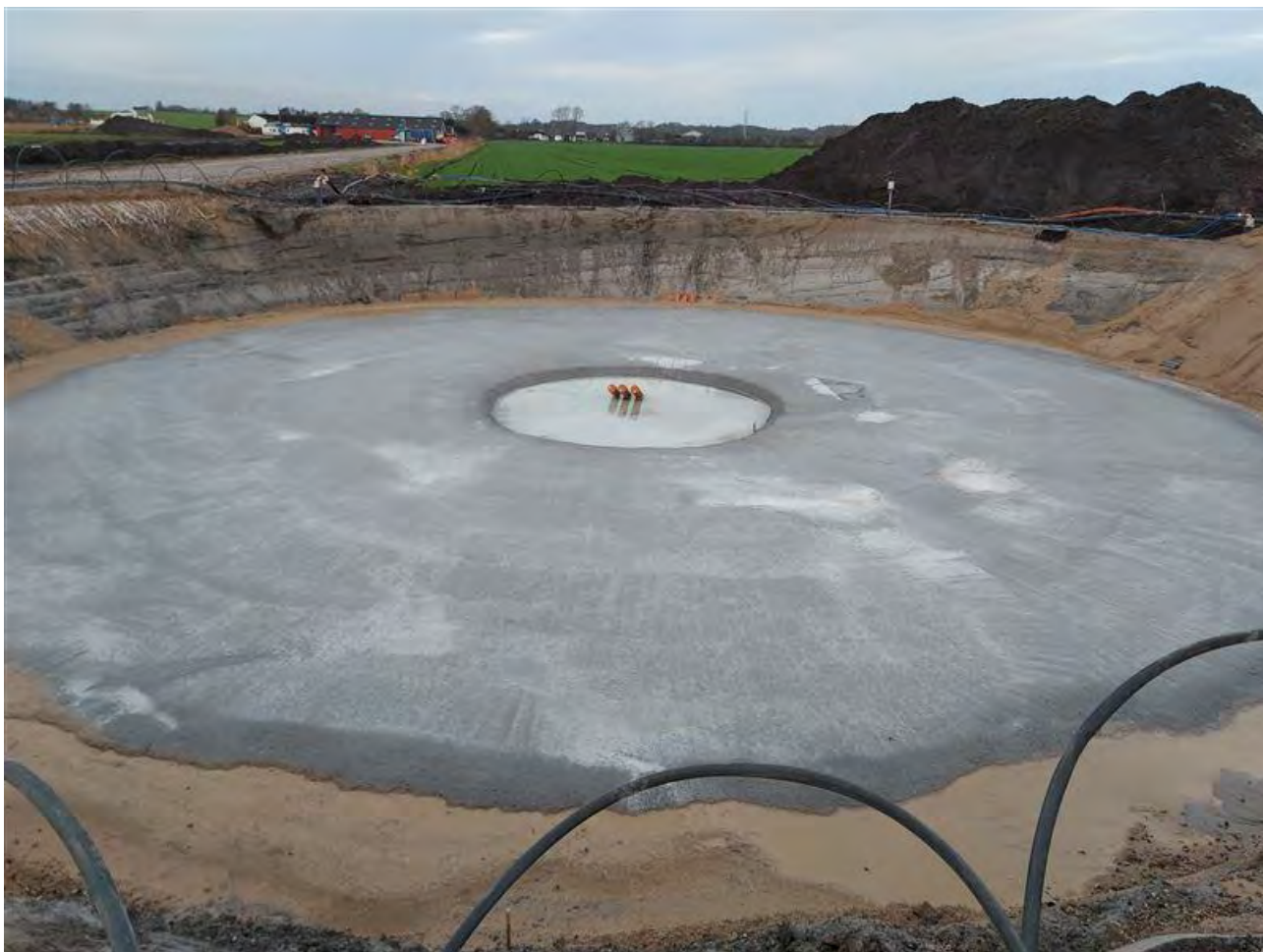
Foto: Eksempel på pladefundament til en Vestas vindmølle.
