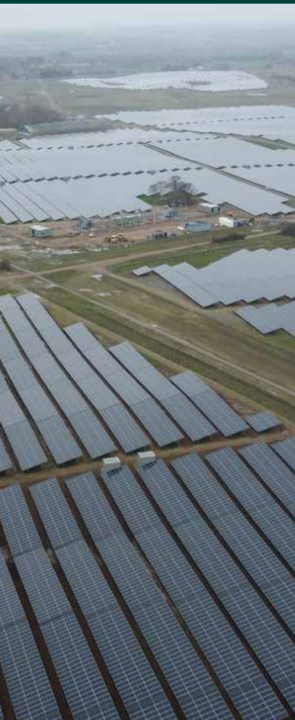
Solcelleanlæg i Håstrup/Viuf Foto: Vejle Kommune
