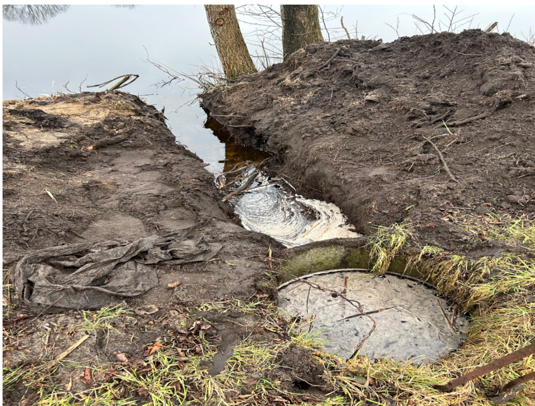
Figur 2: Billede ansøger af den åbne drængrøft der ønskes rørlagt.
