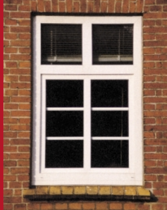
1 Vippevindue i plastic og sprosser mellem termoglasset.
