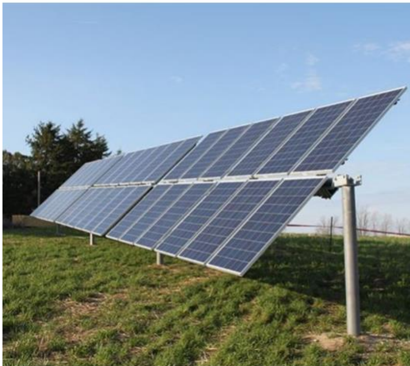
Figur 4: Eksempel på solcelleanlæg med trackersystem
