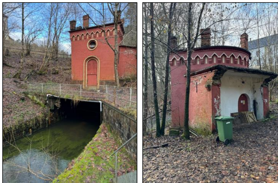
Figur 32: Tv. Turbinebygningen, hvor forløbet af Vejle Å, som løber igennem Randbøldal Turbinen, set i nordvestlig retning. Th. Bagsiden af turbinebygningen set i en sydvestlig retning. (Billeder: Envidan).
