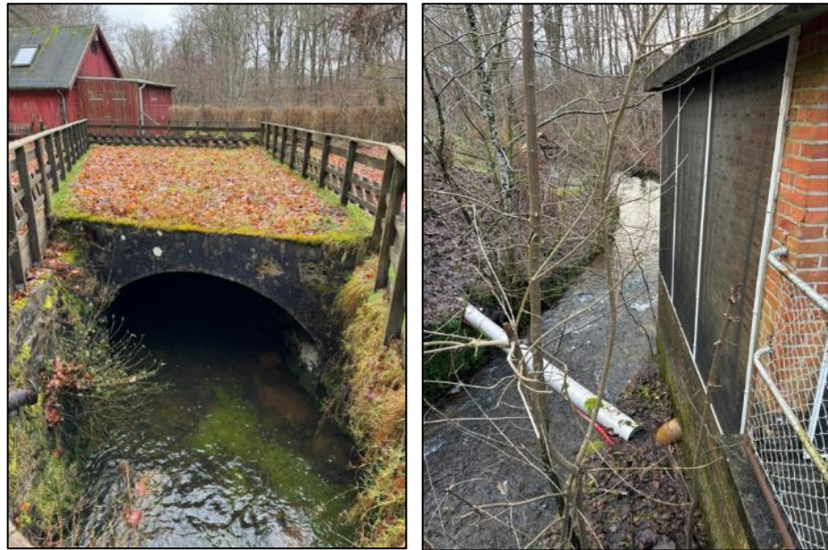
Figur 33: Forløbet af Vejle Å, som løber udenom Randbøldal Turbinen. (Billeder: Envidan). Tv. Set i en nordøstlig retning. Th. set i en sydøstlig retning.
