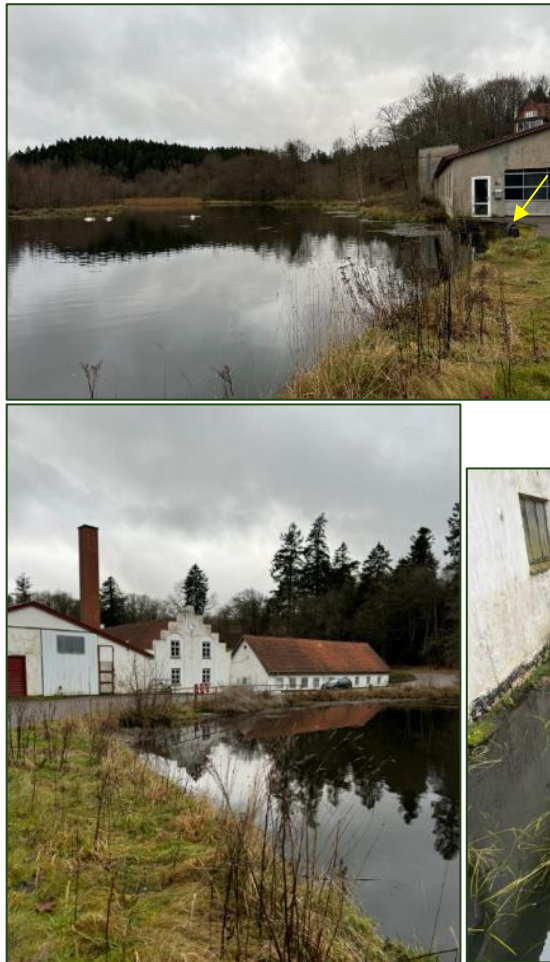
Figur 21: Øverst: Den opstemmede sø, Mølledam, ved Gødding Mølle set fra Gødding Møllevej i nordøstlig retning. Overløb til vandløbet ses foran bygningen, markeret med en gul pil. Nederst tv. Indtag til Gødding Mølle set fra bygningen mod nordvest. Th. turbinen ved Gødding Mølle set fra Gødding Møllevej mod vest. (Billeder: Envidan).
