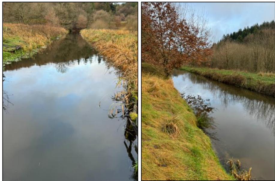
Figur 23: Indløbskanalen (den Grønske kanal) set i nordvestlig retning, som løber til turbinen ved Markedspladsen (den grønne stiplede linje på Figur 22). (Billeder: Envidan).
