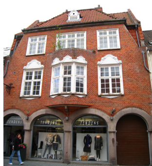
Butiksfacade md respekt for det oprindelige udtryk
