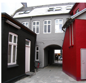
Nutidig farvesætning af side og bagbygninger
