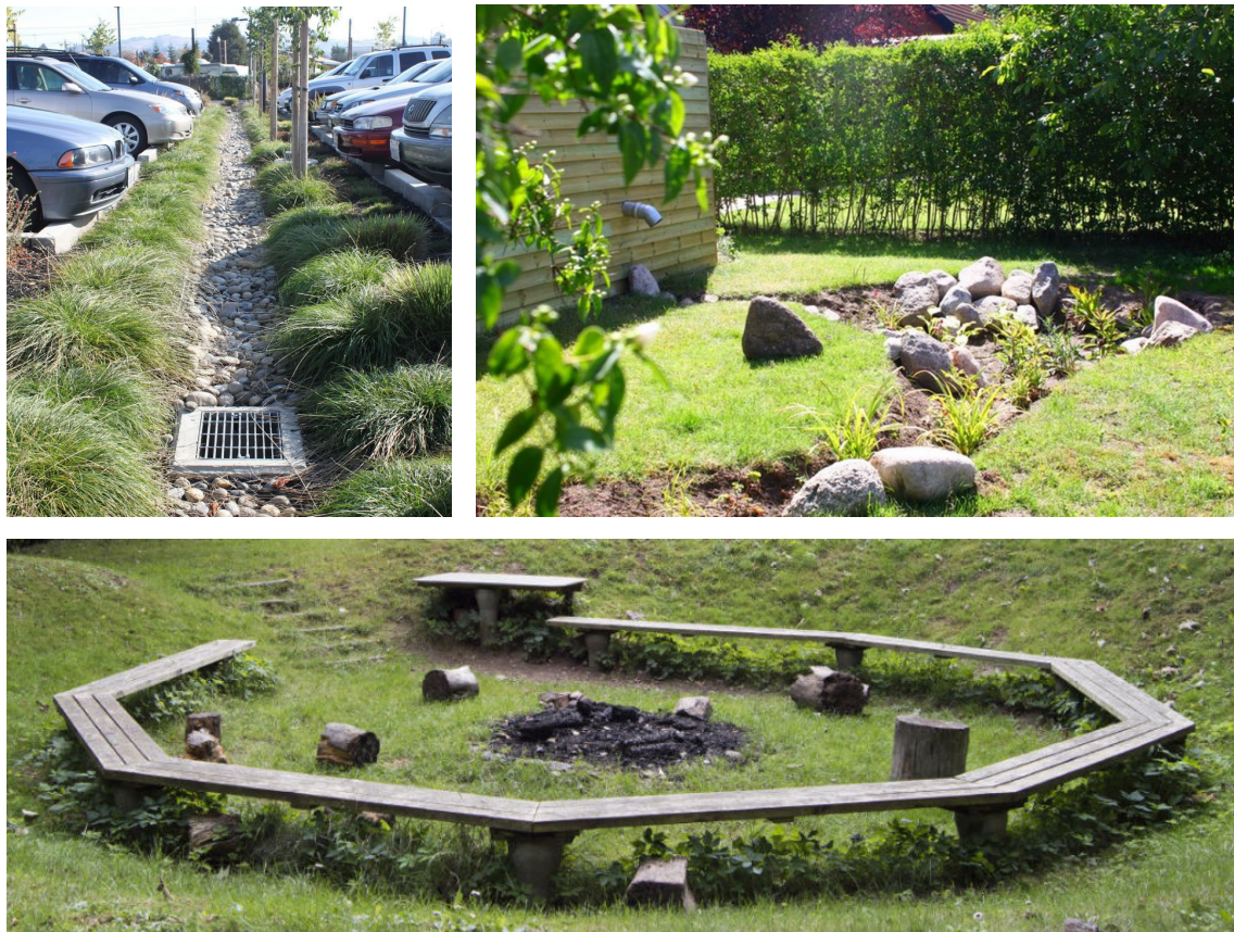
Figur 6. Fotos med eksempler på håndtering af klimavand - render med sten og bålplads i lavning
