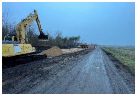
Anlægsarbejde på Hedevej
