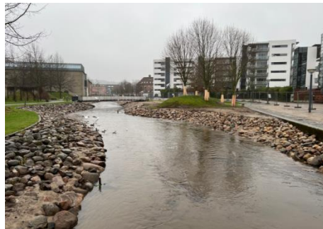
Stensætning ved Omløbsåen
