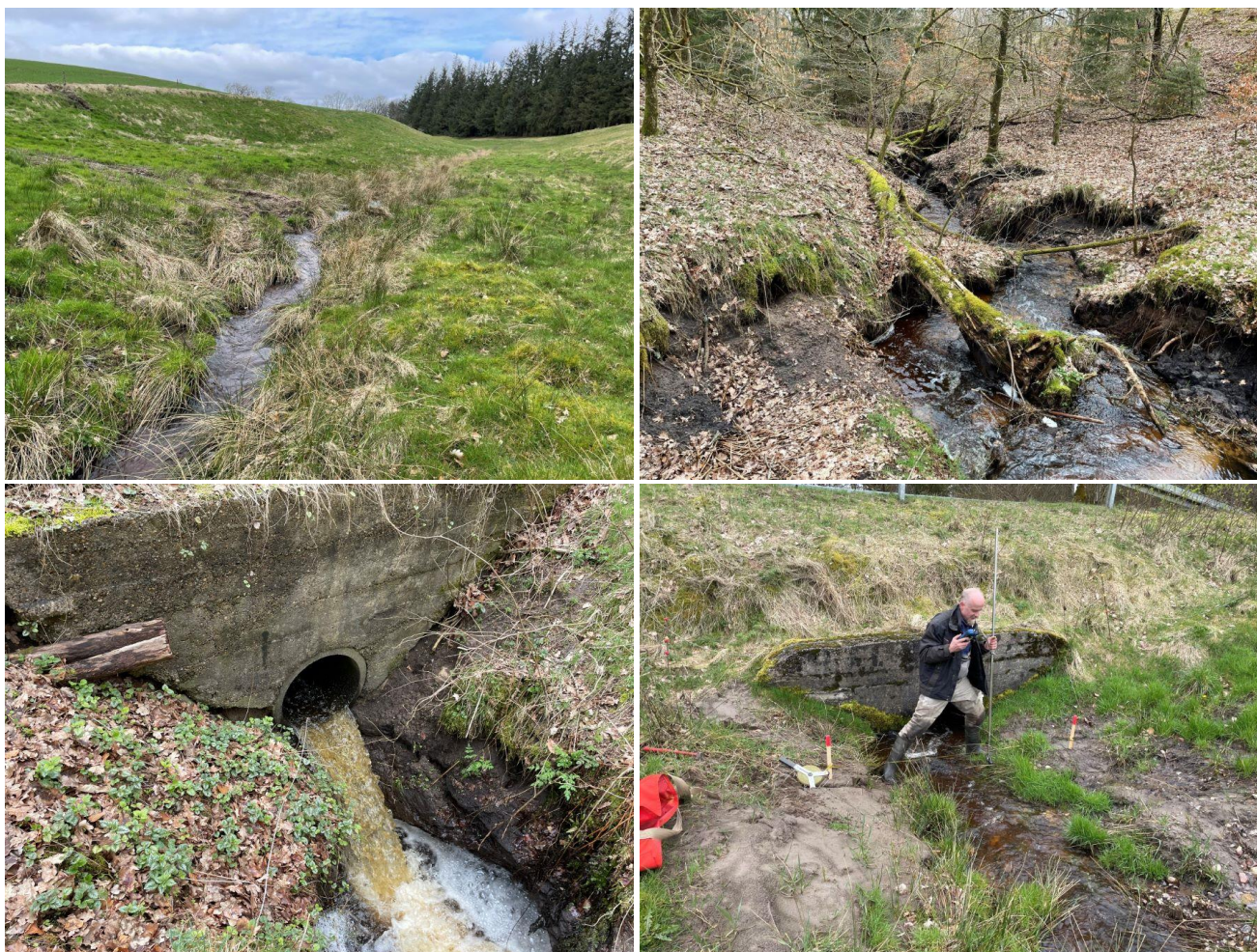
Figur 11.2: Fotos fra „Tilløb 1 – Groest“, taget den 3. april 2024 (i en periode med høj vandføring). Fotos: Niras A/S.
