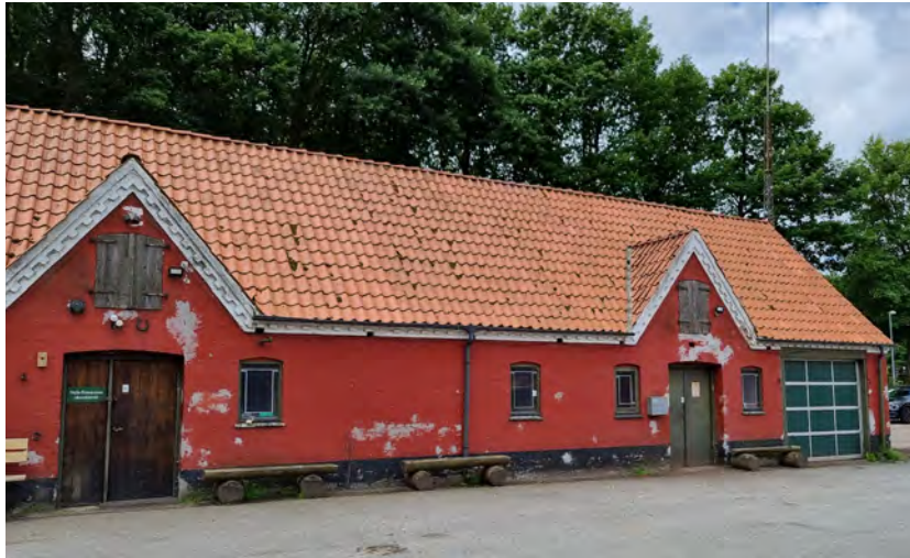
Figur 2: Billedet viser eksisterende hovedbygning ved Vejle Kommunes Materielgård.
