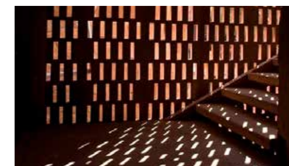
EVT. PERFORERING I TEGLVÆRK BRUGES TIL AT REGULERE AKUSTIKKEN
