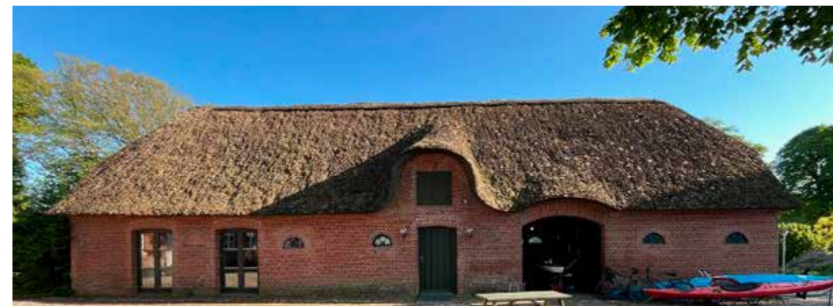
EKSISTERENDE SOGNEHUS FACADE I DAG
