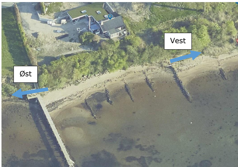
Figur 1 viser strand, eksisterende kystbeskyttelse, skrænt og bebyggelse ved Vigen 80 (ansøgningstrækningen)
