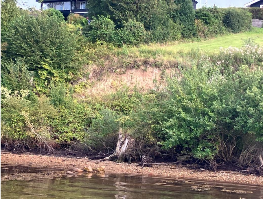
Figur 4 foto der viser skred i skrænt (akut erosion) lige øst for Vigen 80 på strækning uden kystsikring
