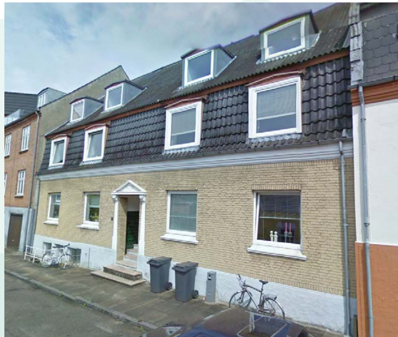
Ved Vandværket - fotograf: Teknik & Miljø 2006
