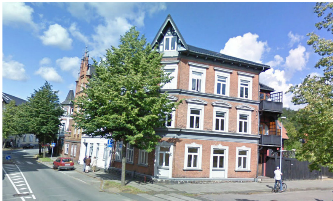
Skyttehusgade/Steensvej - fotograf: Teknik & Miljø 2006
